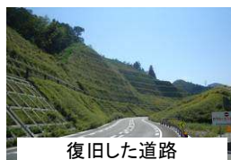
復旧した道路
